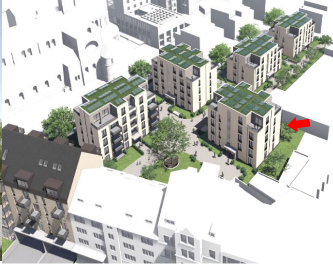
Ansicht Nord - Eingang
