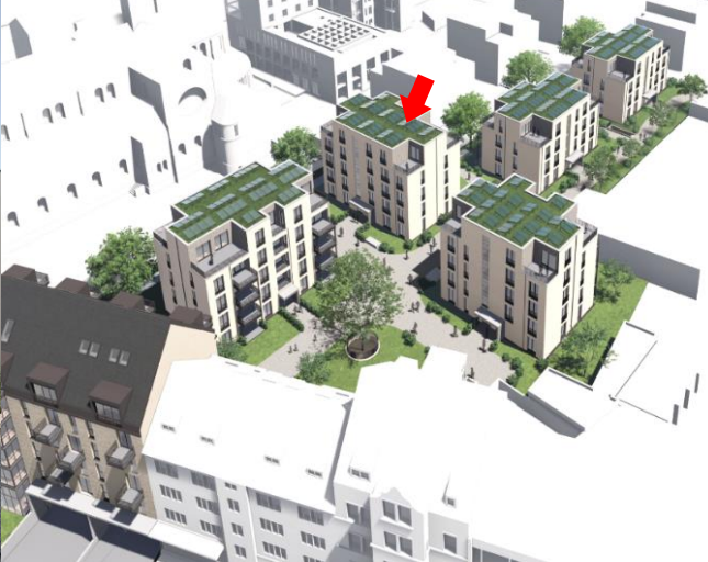
Ansicht Nord - Eingang
