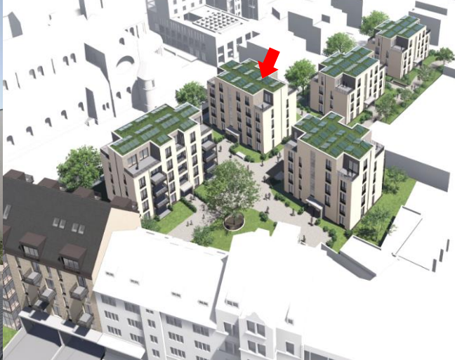
Ansicht Nord - Eingang
