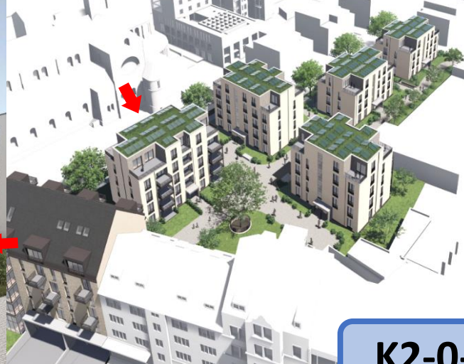
Ansicht West - Eingang
